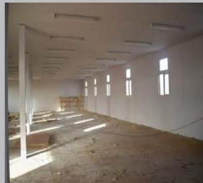
**السقف الداخلي:** يتم عمل السقف الداخلي بواسطة ألواح بليود سماكة ٤-٦ ملم مثبت على إطار خشبي ثم يتم التشطيب من الداخل بعمل رشة أمريكية ثم الدهان بالزيت المطفي.
